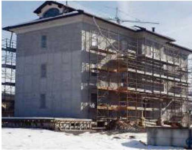
Il cantiere edile di un palazzo in costruzione
